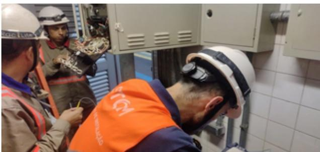
REALIZADA A FUSÃO NAS FIBRAS ÓPTICAS E TESTES, NO GABINETE SALA TÉCNICA (GST), COM O EQUIPAMENTO ODTR. ESTAÇÃO TATUAPÉ - LINHA 12
